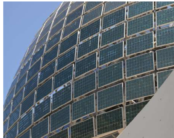
Il. 1-3. Plastyka budynku i detal Le Seine Musicale w Paryżu. Ruchomy słoneczny żagiel jako ochrona przeciwsłoneczna i wytwórnik prądu. Foto: J. Figaszewski.
