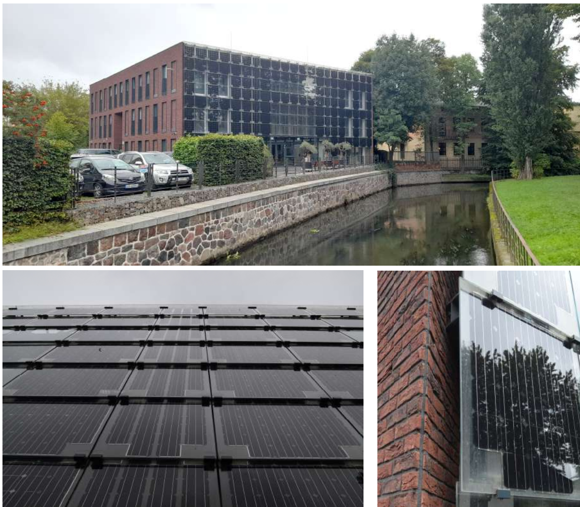
Il. 4-6. Wyeksponowana na południe fotowoltaiczna fasada siedziby WFOŚiGW w Gdańsku. Budynek zaprojektowany przez pracownię Biuro Projektów A-Plan. Foto: J. Figaszewski
