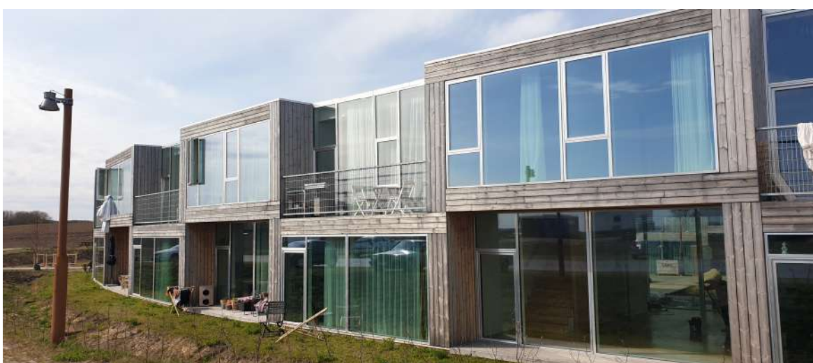
Il. 9. Detal elewacji
