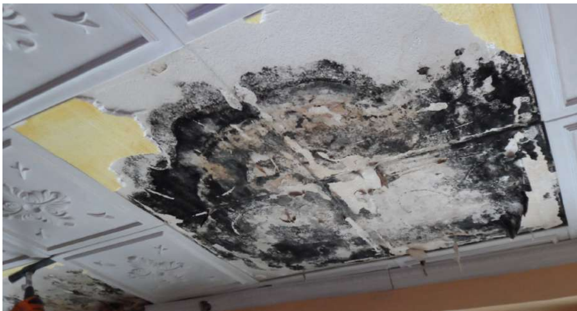
Il. 1. Kolonia grzybów pleśniowych powstała na suficie pod kasetonami z tworzywa sztucznego
