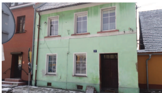
Photo 9. Building on the square Wolności 7.
